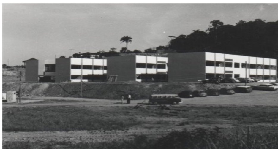
Figura 44 – Construção dos Blocos A, B, C do campus 1 em 1969
