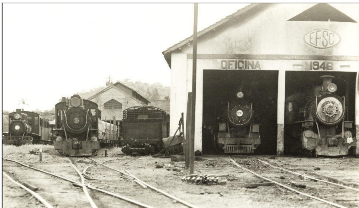
Figura 5 – Vista do pátio da Oficina Mecânica da Estrada de Ferro de Santa Catarina (E.F.S.C.), aparecendo dois galpões – Futuro campus 2.
