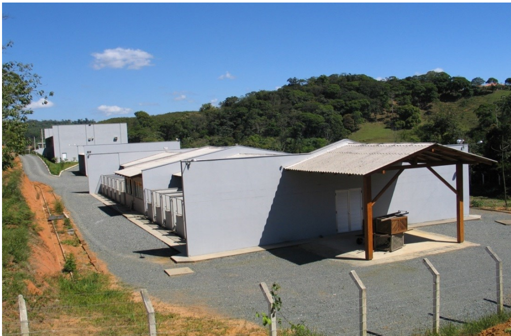
Figura 15 – Vista parcial do Biotério, aos fundos, e em frente, o Canil - campus 5.
