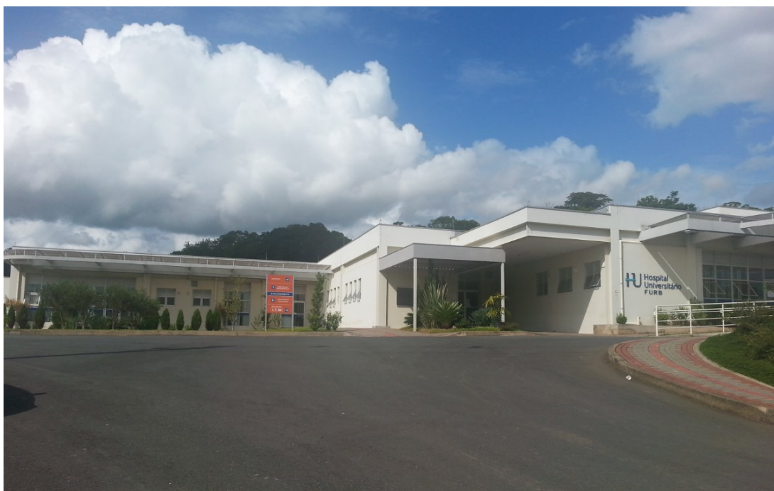
Figura 17 - Fachada do Hospital Regional Universitário.
