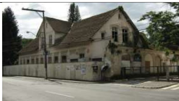
Situação Atual – Frontal/lateral
