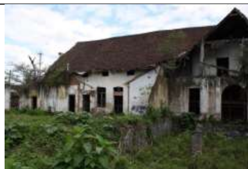
Situação Atual - Fundos
